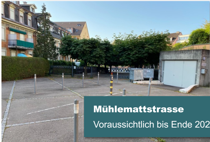
Mühlemattstrasse/Eigerstrasse Hauptinstallationsplatz, während der gesamten Bauzeit in Betrieb
