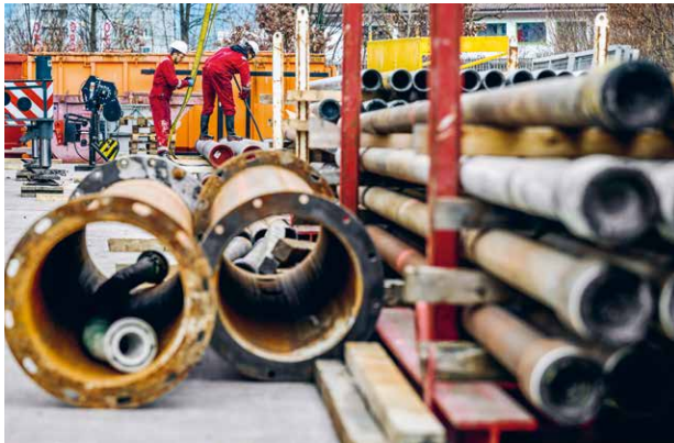
Material für die Bohrarbeiten
